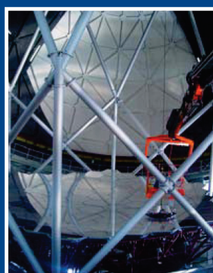
Элементы главного зеркала установлены в телескоп Primary mirror elements are installed into telescope
